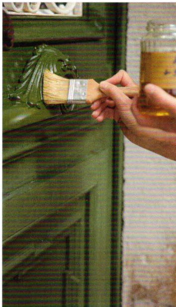
Abb. 7 und 8 Matte Oberflächen zeigen ihren Pflegebedarf an. Das Nachölen kann mit einem normalen Borstenpinsel erfolgen. Das Leinöl wird, hier mit 5%igem Zusatz an Leinöl-Standöl, auf die gereinigte Oberfläche aufgestrichen. Fotos © Gohmri Wolf-Khosrowi
